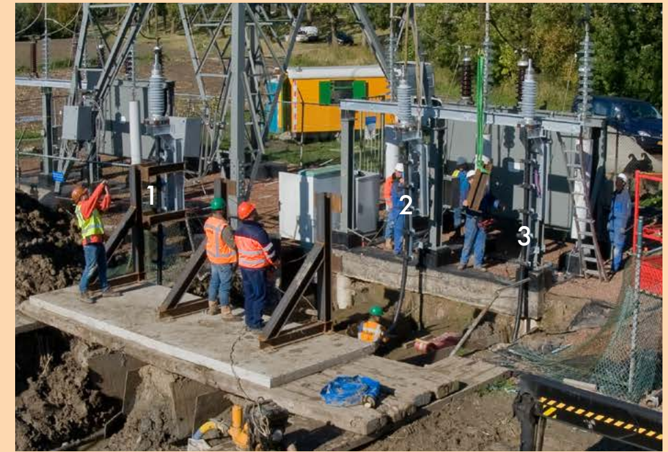
Foto 8-4. Hulpconstructie (foto credit: Paul van der Zwet).
